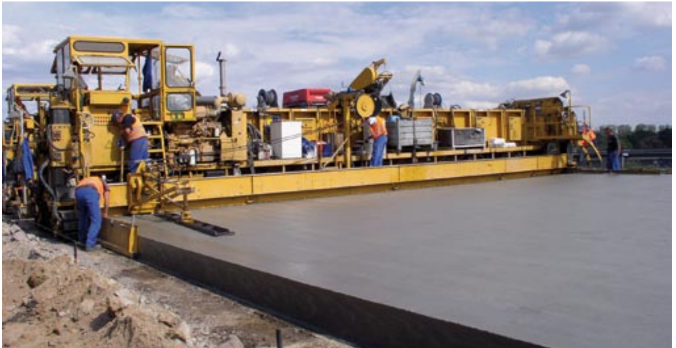
Bild 4: Glätten der fertig eingebauten Betondecke
