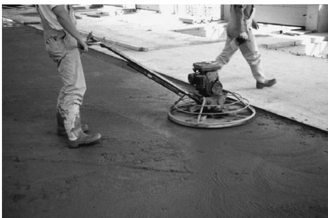
Bild 6: Maschinelles Abscheiben der Betonoberfläche
