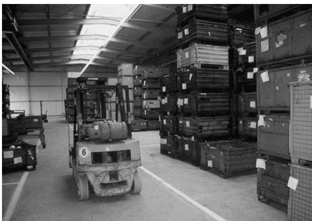
Bild 1: Industrieboden aus Beton mit Staplerverkehr
