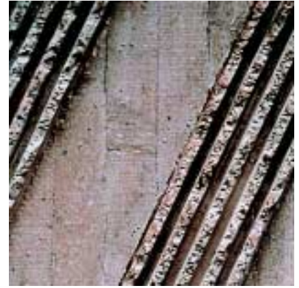
Bild 4: Strukturierte und raue Betonoberfläche, Reckli-Strukturschalung Nr. 1/21 Malta und sägerauhe Brettschalung, Portlandölschieferzement
