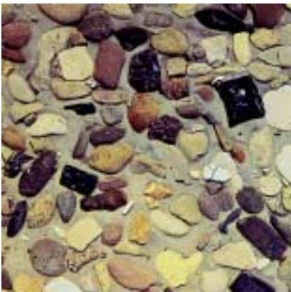
Bild 5: Ausgewaschene Betonoberfläche, farbiger Zuschlag mit rundem Korn, grauer Zement
