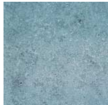
Bild 1: Glatte Betonoberfläche, Betopfanschalung, grauer Zement
