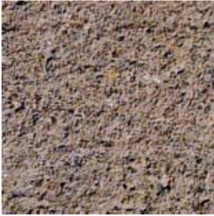
Bild 8: Gestockte Betonoberfläche, heller Zuschlag, Portlandölschieferzement
