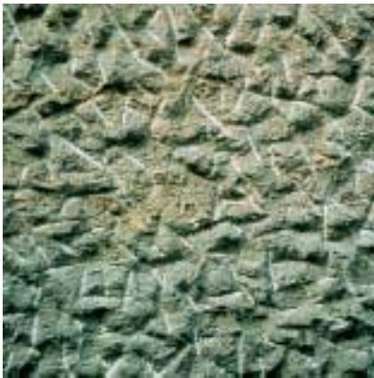
Bild 11: Bossierte Betonoberfläche, Kalkstein, grauer Zement
