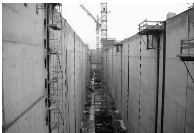
Bild 10: Blick in die Nordkammer der Doppelschleuse Hohenwarthe, Kammerwandhöhe 24,45 m (aus [14])
