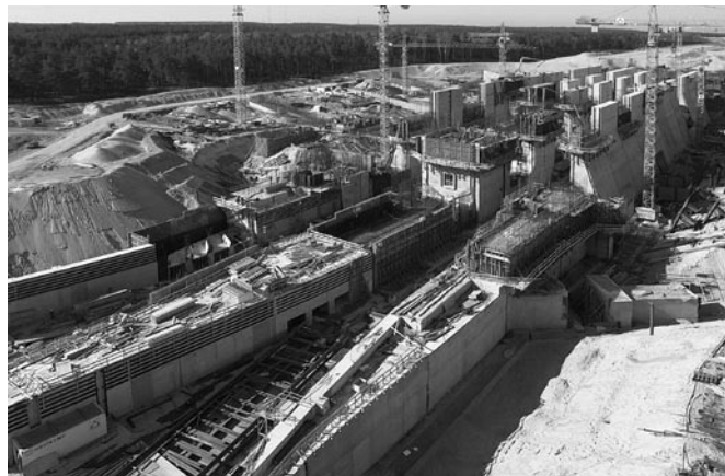
Bild 9: Schleuse Hohenwarthe im Bauzustand (aus [14])
