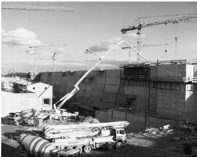
Bild 8: Betoneinbau im Bereich des Oberbaus der Doppelschleuse Hohenwarthe (aus [14])
