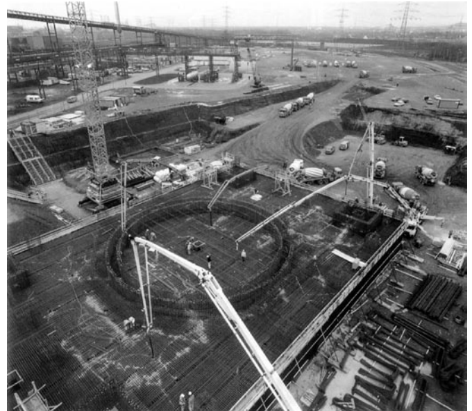
Bild 7: Betoneinbau in das Fundament für den Hochofen 2 der Thyssen Stahl AG in Duisburg-Schwelegern (aus [13])
